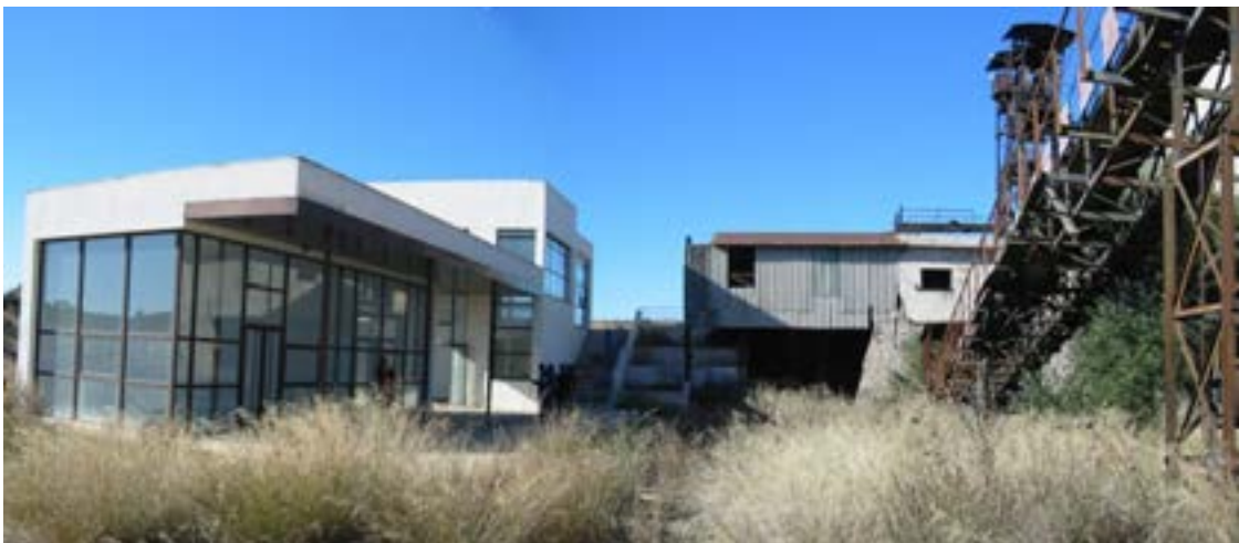
Fotografía 5. Pozo San José y su añadido
