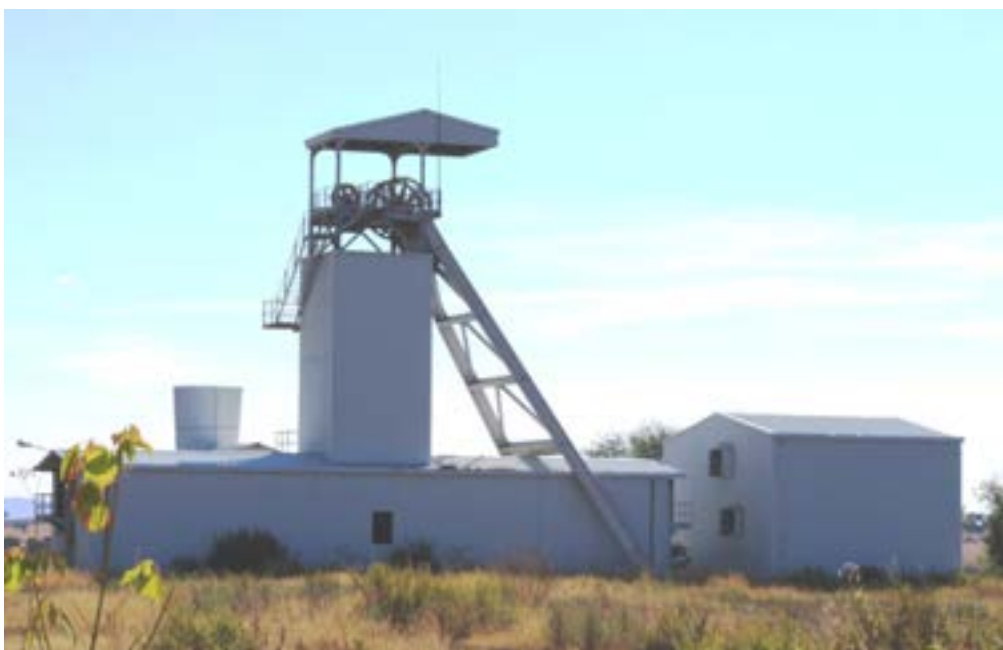
Fotografía 9. Pozo de ventilación de Mina María
