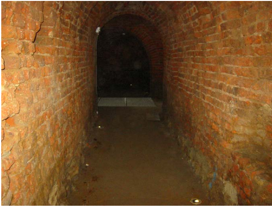
Galería reforzada con piedra y ladrillo
